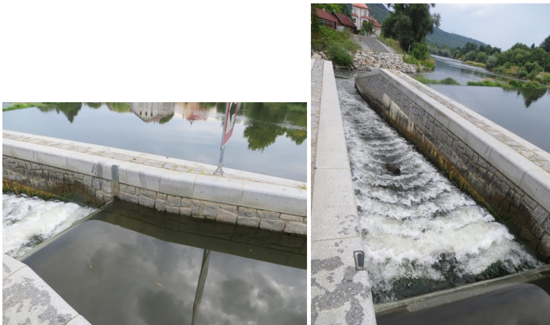
Obr. 4.2 Pohled na stávající sportovní propust s osazeným hrazením v drážkách provizorního hrazení.
