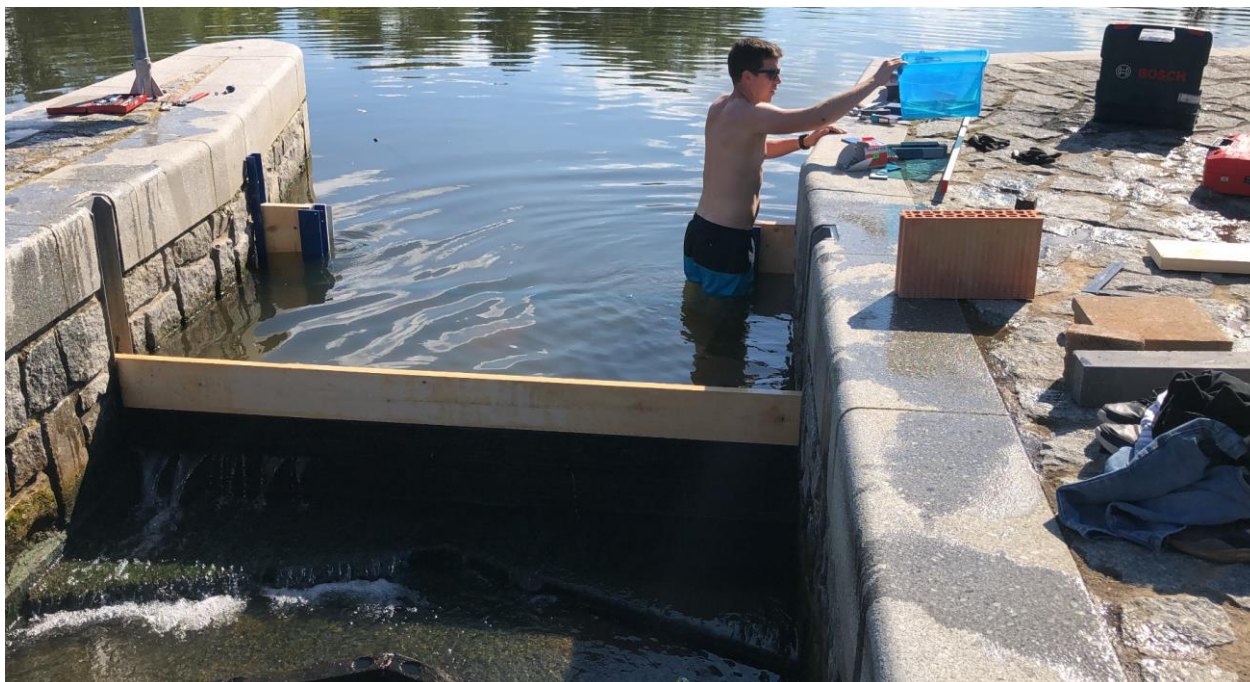
Obr. 5.7 Instalace rámu do sportovní propusti (16. 9. 2023).
