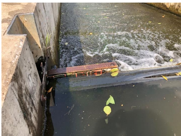
Obr. 2.2 Detail kontaktu pevné a pohyblivé části uzávěru.
